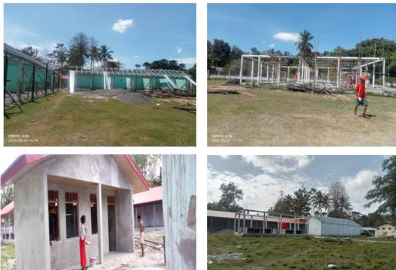
Figura 32 - Rehabilitasaun Infrastrutura Merkadu iha Olobay, Viqueque Villa
